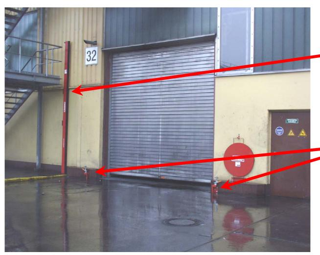
Löschwasserbarriere zur Torabdichtung.
