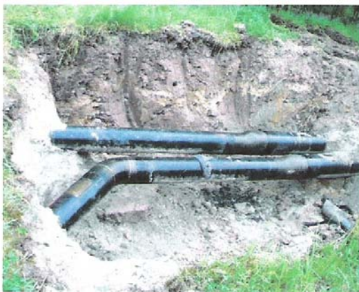
Rohrleitungen freigelegt zu Wanddickenmessung
