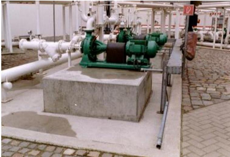
*Förderpumpen für Kraftstoffe und Heizöl in einer Pumpentasse:*
