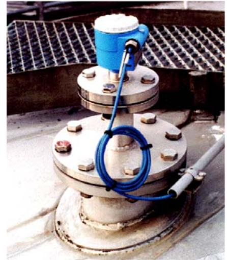
Der Füllstand ist die Höhenlage einer Messstoffoberfläche über einer Bezugsgröße. Der höchstzulässige Füllstand ist der Füllstand, der eine Überfüllung des Tanks/Behälters etc. verhindern soll. Bei den Überfüllsicherungen gibt es bis heute keine Bauart, die gleichzeitig alle Anwendungs – und sicherheitstechnischen Anforderungen erfüllt.
